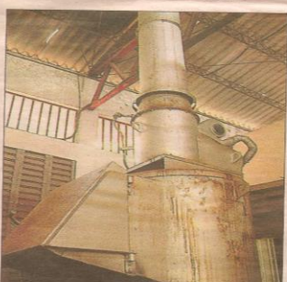
Planta. Aquí eran incinerados varios desechos peligrosos.
