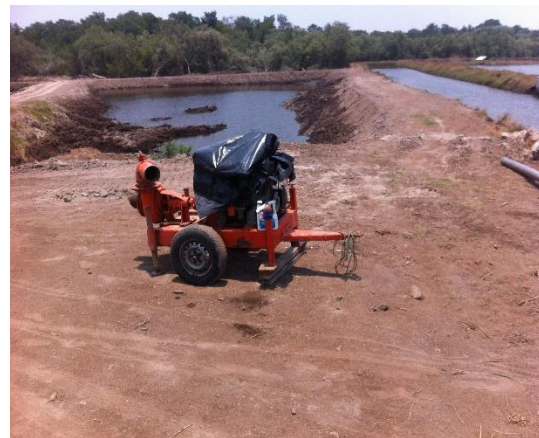
Construcción de nuevo estanque.
