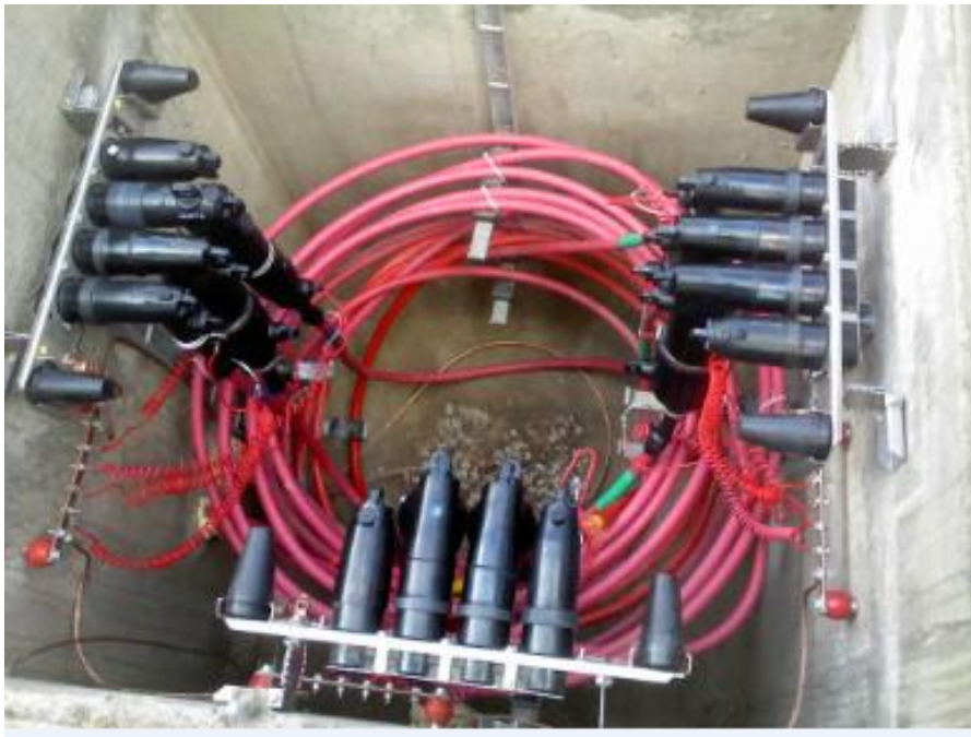
Figura 3. 18. Conexión de los inversores.
