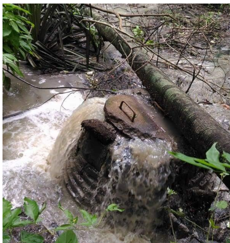
Figura 6. Ruptura de la cañería en el caserío Sisiniapa.
