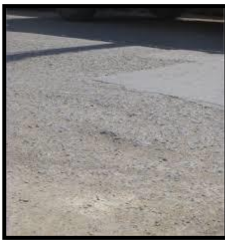
Figura: 0.13: Peladura.
