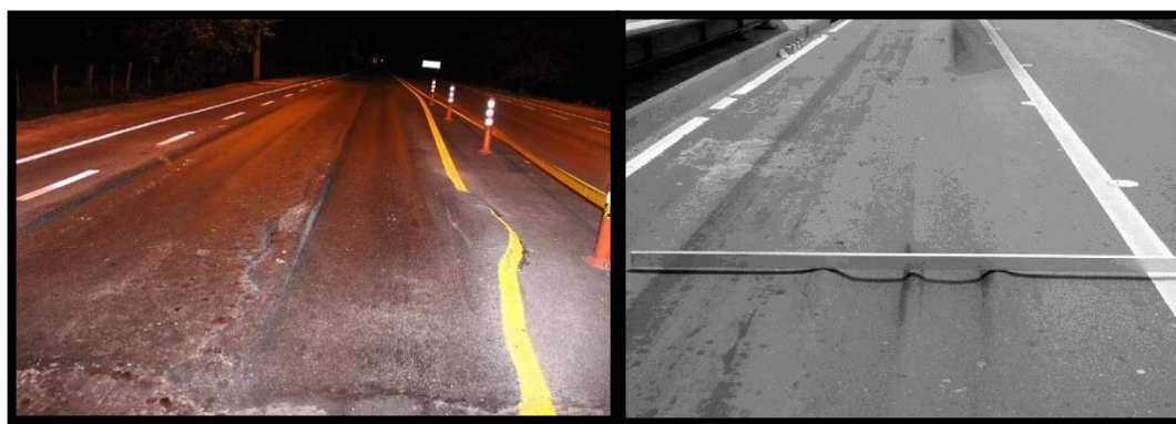
Figura: 0.7: Ahuellamientos.
