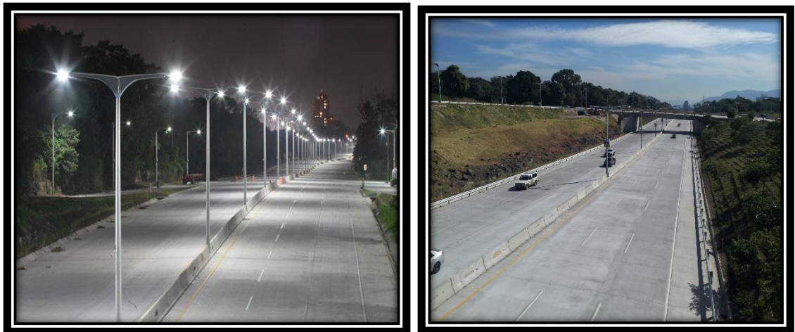
Figura: 0.3: Boulevard Monseñor Romero, Pavimento Rígido.
