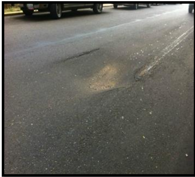
Figura: 0.11: Hundimiento.
