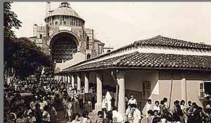
FOTO DE CONSTRUCCIÓN EN 1,978
