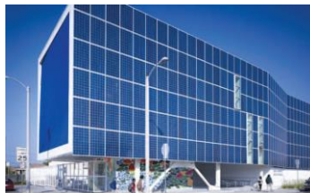
Montaje en fachada
