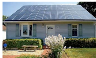
Montaje en fachada
