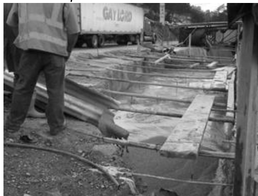
Figura 2.12 Relleno entre muro de contención y derrumbe dos días después.
