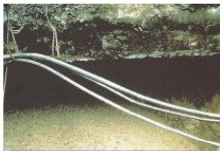
Figura 7. Con el empleo de MBRC no es preciso volver a recortar los bordes de la cala, en caso de desplomes laterales
