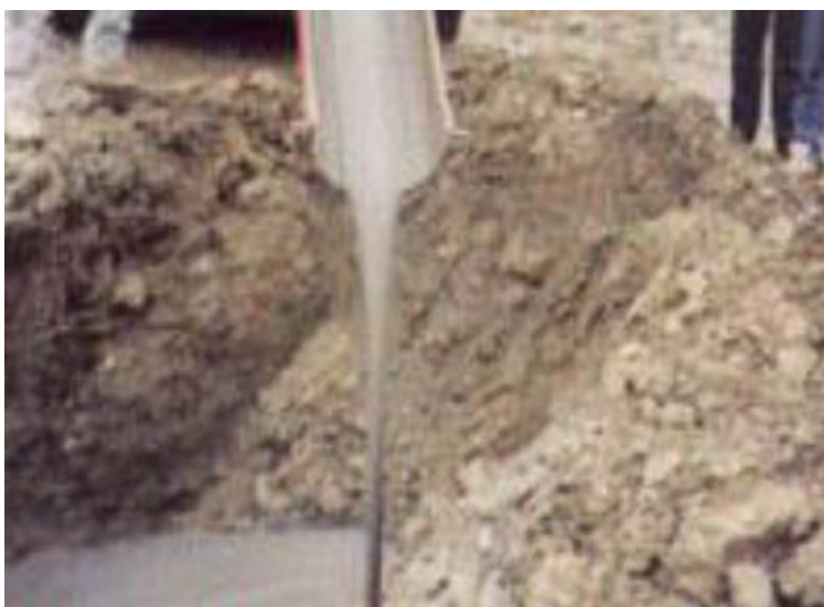
Figura 2.16 Vertido directo de la canaleta del camión. 51
