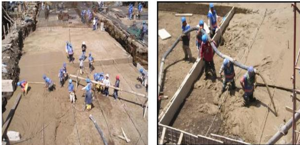
Figura 2.19 Aplicación de MRBC en rellenos estructurales 54
