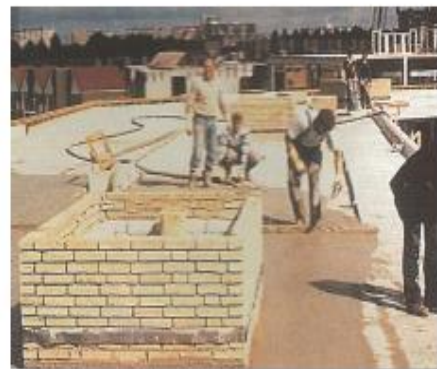
Figura 14. Formación de una capa aislante con mortero ligero en una cubierta
