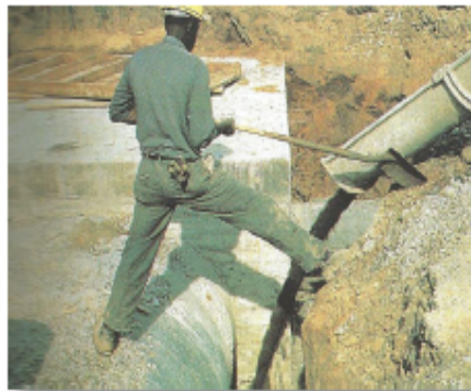
Figura 11. Relleno de una pequeña obra de fábrica
