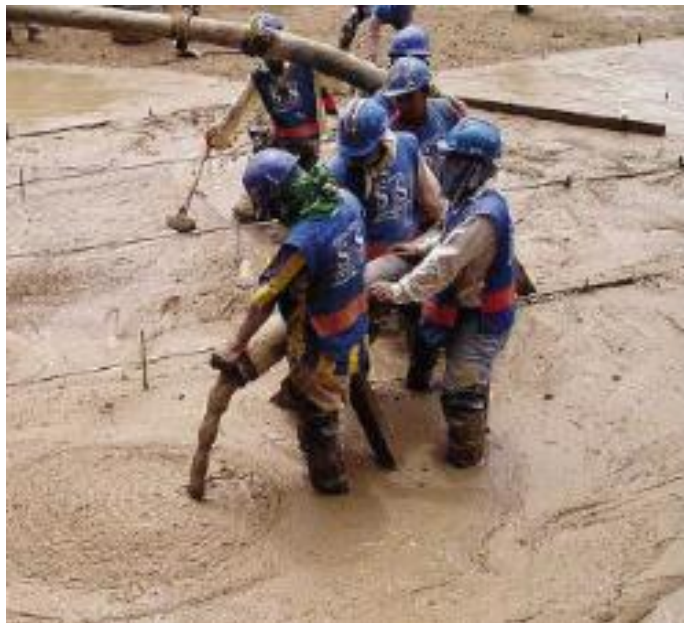
Figura 2.17 Colocación de MRBC por bombeo a través de tubería 52
