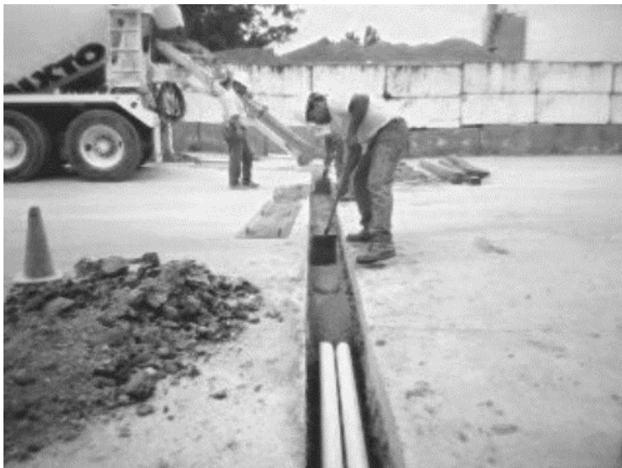
Figura 2.10 Aplicación de MRBC en Zanjas 44
