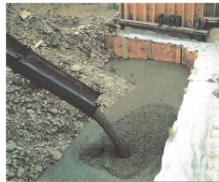
Figura 12. Relleno de un trasdós de estribo
