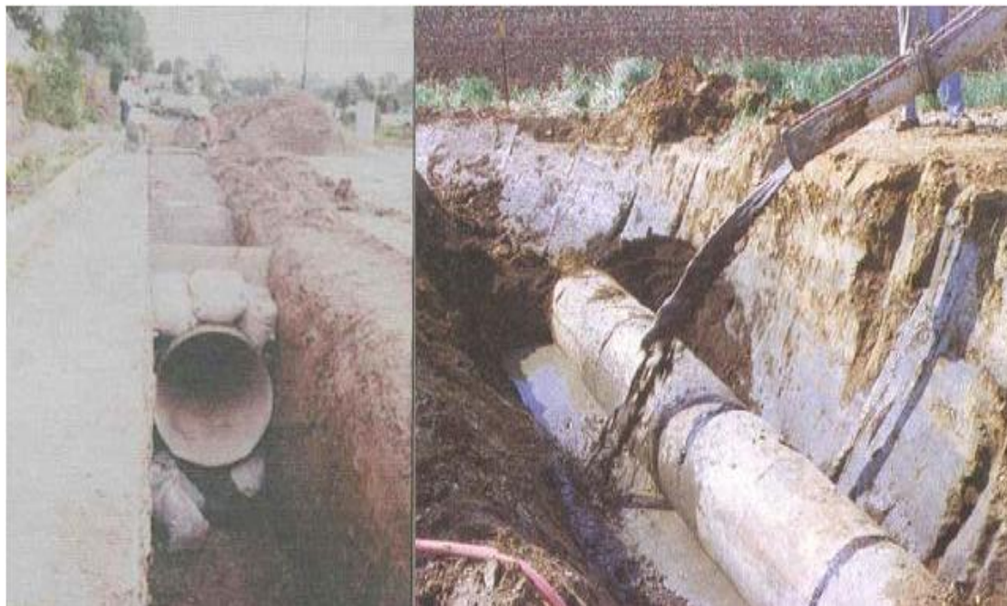
Figura 2.18 Colocación de MRBC en tuberías
