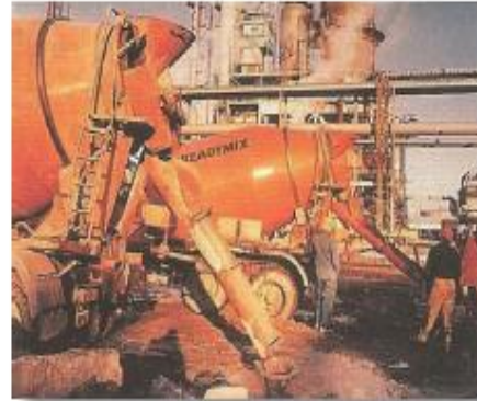
Figura 13. Relleno de un depósito subterráneo fuera de servicio
