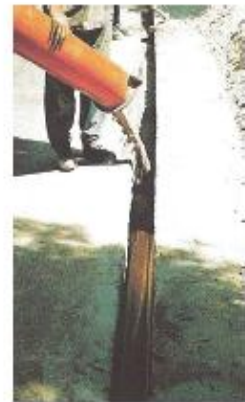
Figura 8. Relleno de una zanja estrecha para una canalización de gas natural
