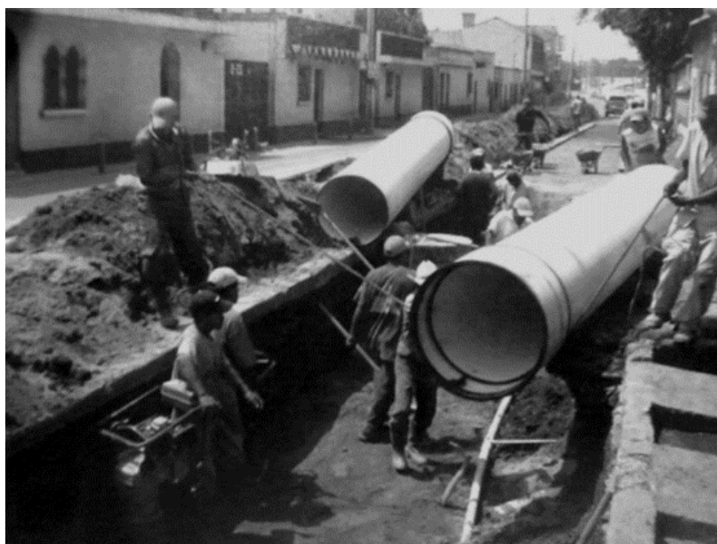
Figura 2.9 Encamamiento de Tubería sin aplicar MRBC 43
