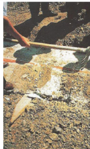
Figura 10. Excavación a mano de un MBRC
