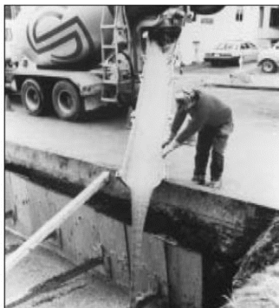
Figura 2.15 Vertido directo de la canaleta del camión 50
