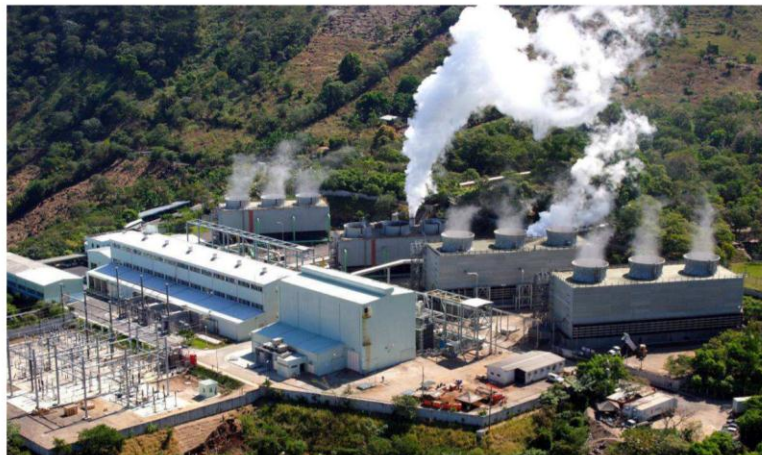
Ilustración 7. Vista general de las instalaciones de la Planta Geotérmica en Berlín, Usulután.
