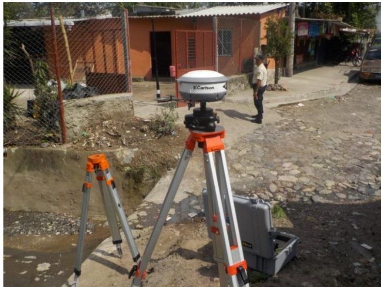
Figura 3.2.1 Estación base de GPS para el levantamiento topográfico.
