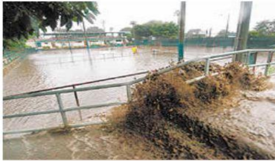
a) Canchas inundadas en el Polideportivo de Merliot
