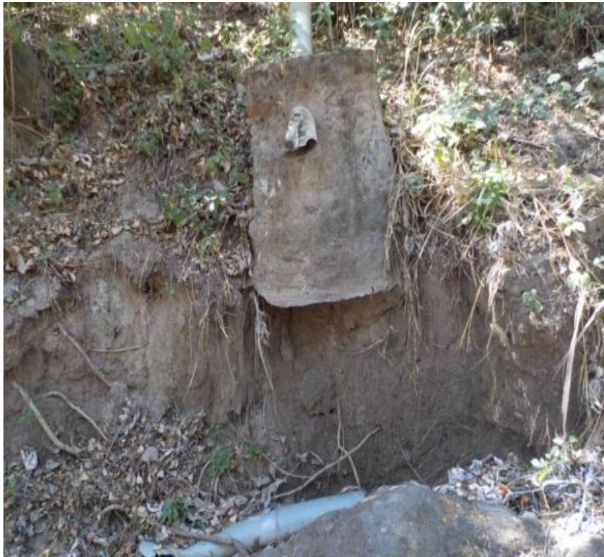
Figura 3.3.6 Drenaje de zona urbanizada en las cercanías directamente a la Quebrada Las Lajas San Salvador.
