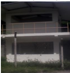
FOTOGRAFÍA N° 5 FACHADA DE LA ENTRADA DE LA 5ª BRIGADA DE LA FUERZA ARMADA
