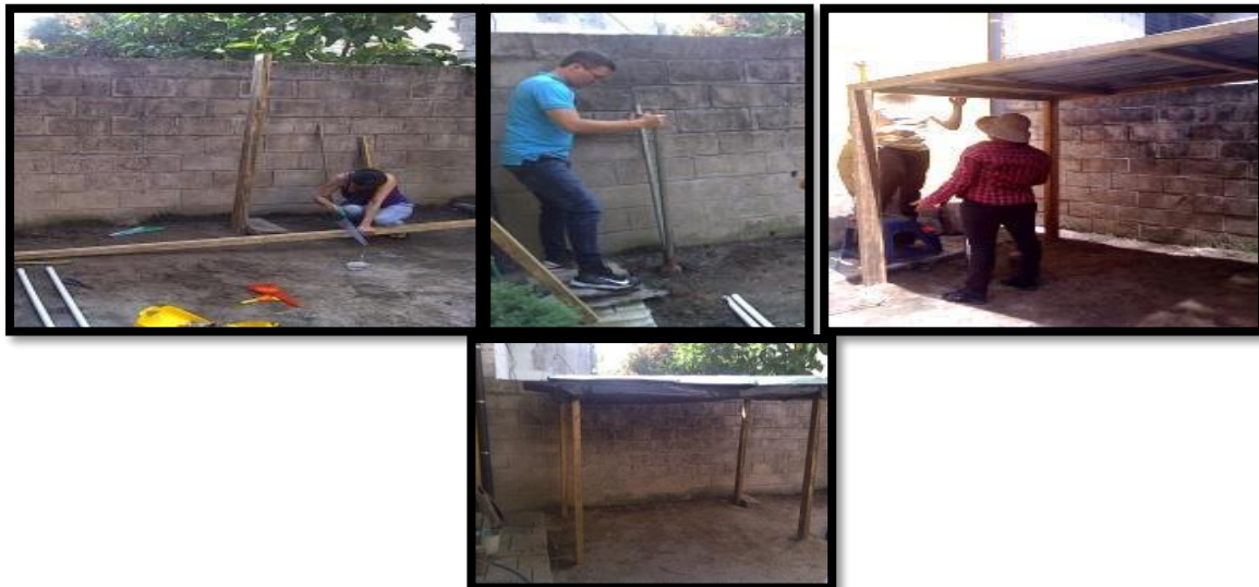
Figura N° 19: Construcción y adecuación de instalaciones.
