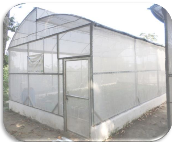
Figura A-1. Invernadero de forma semi-circular, con una ventana cenital en la parte superior del techo. UES-CC. AA. Tesis 2017.
