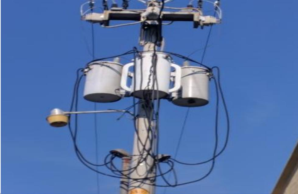
**Figura H1:** subestación de 225KVA.
