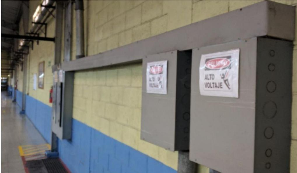
**Figura H6:** Cajas de registro para acometidas a sub-tablero de fuerzas.
