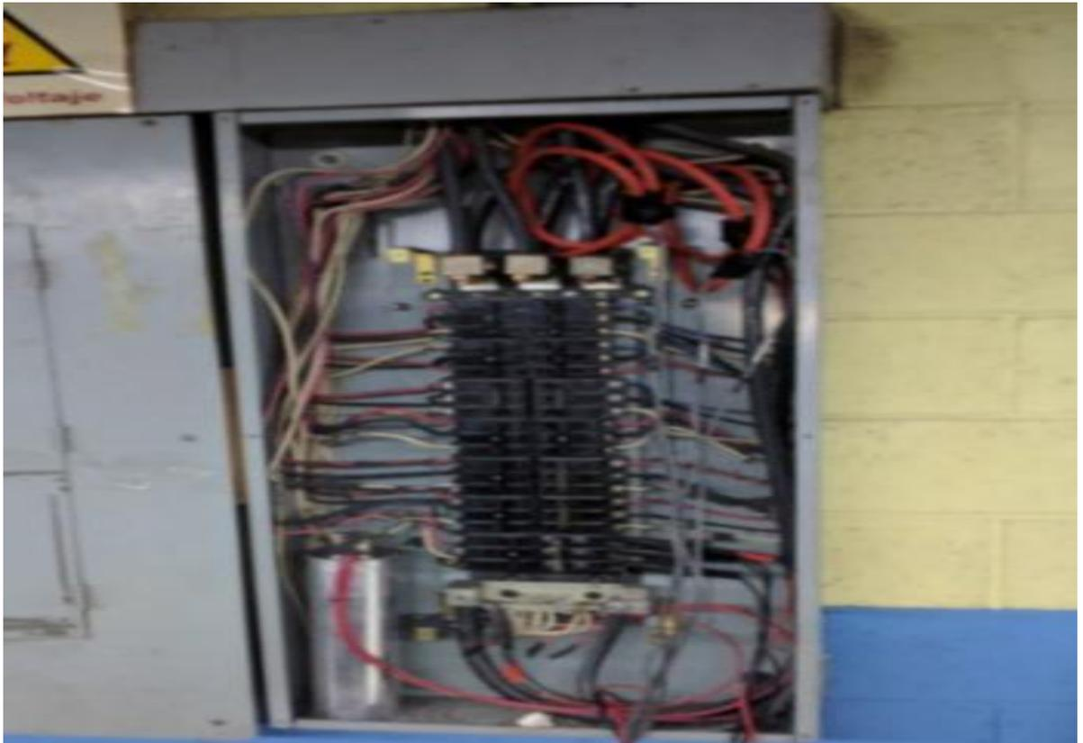
**Figura H7:** Medición en sub-tablero de fuerza
