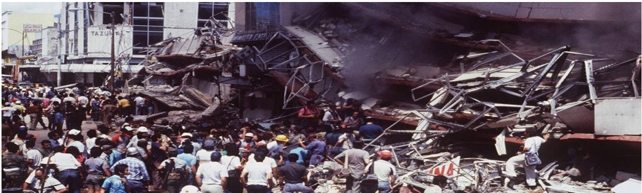
Fig. 73 Escombros del edificio Rubén Darío, minutos después del terremoto de 1986 (Bommer, J. 1996).
