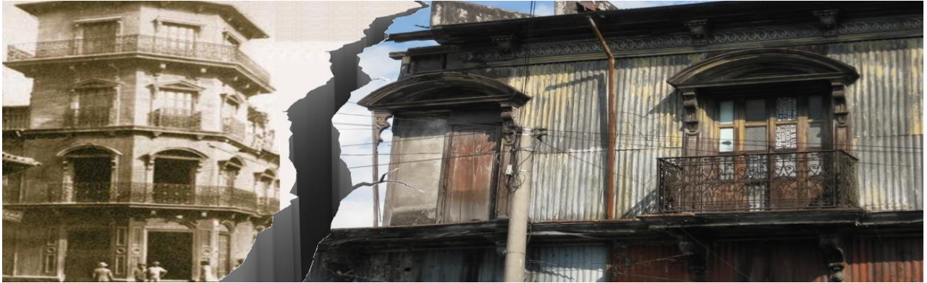
Fig. 77 Antes y después del terremoto de 1986. Casa Ambrogi. (Nuestros Edificios. 2013)
