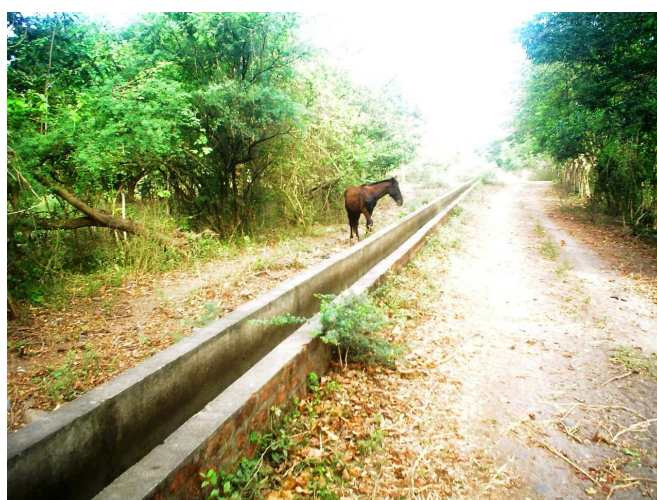
Figura 10. Acceso de una bestia caballar a la canaleta de riego en el Distrito de Riego y Avenamiento N° 3 Lempa Acahuapa.
