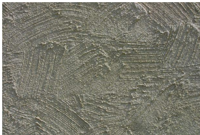
Figura 5.2 Imagen ilustrativa de aplicación de estuco comercial
