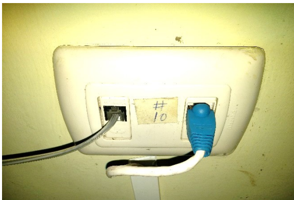
Figura 68. Puerto de Unidad Central, previo al etiquetado.
