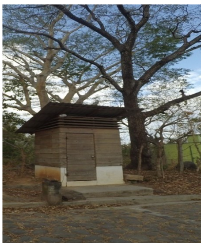
Figura 33. Cuarto eléctrico para suministrar las antenas del Parque Ecoturístico Tehuacán.
