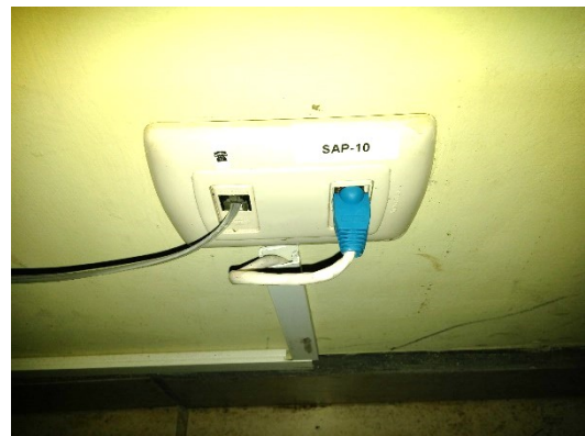
Figura 69. Puerto de Unidad Central, después del etiquetado.
