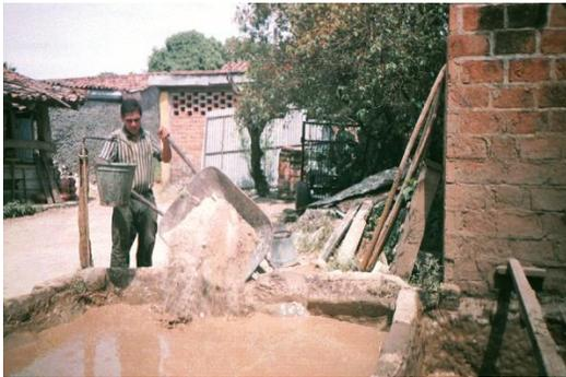
sobrecargue en el cabo del azadón toda la fuerza, evitando hacer esta sólo con los brazos. De esta manera se repetirán sucesivamente los movimientos, hasta lograr que se vuelva una mezcla cremosa y homogénea lista para ser utilizada en el siguiente proceso.
