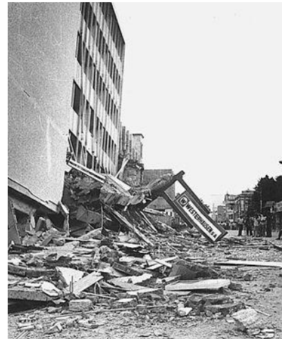
Edificio El Gran Hotel San Salvador.
