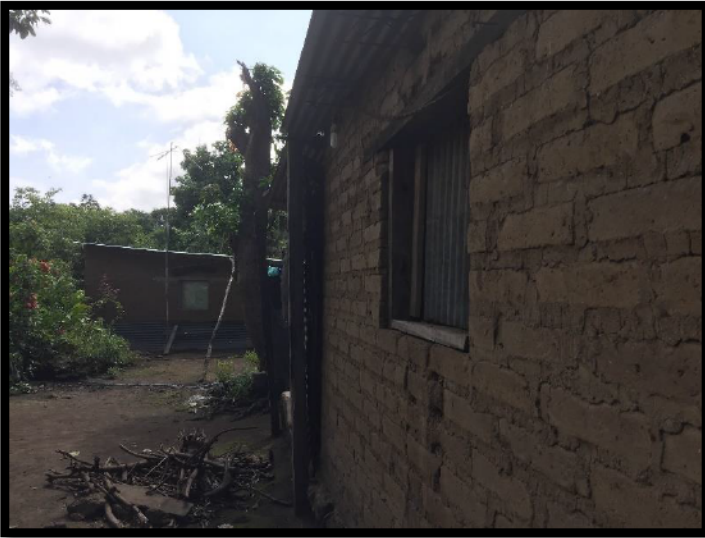
Vivienda de Adobe
