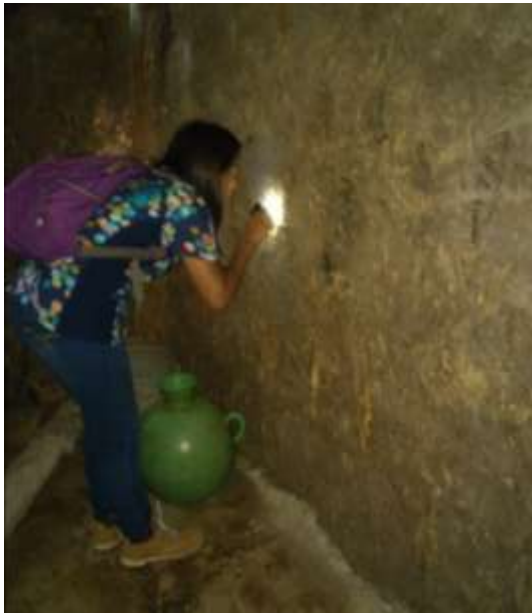
Inspeccion de viviendas
