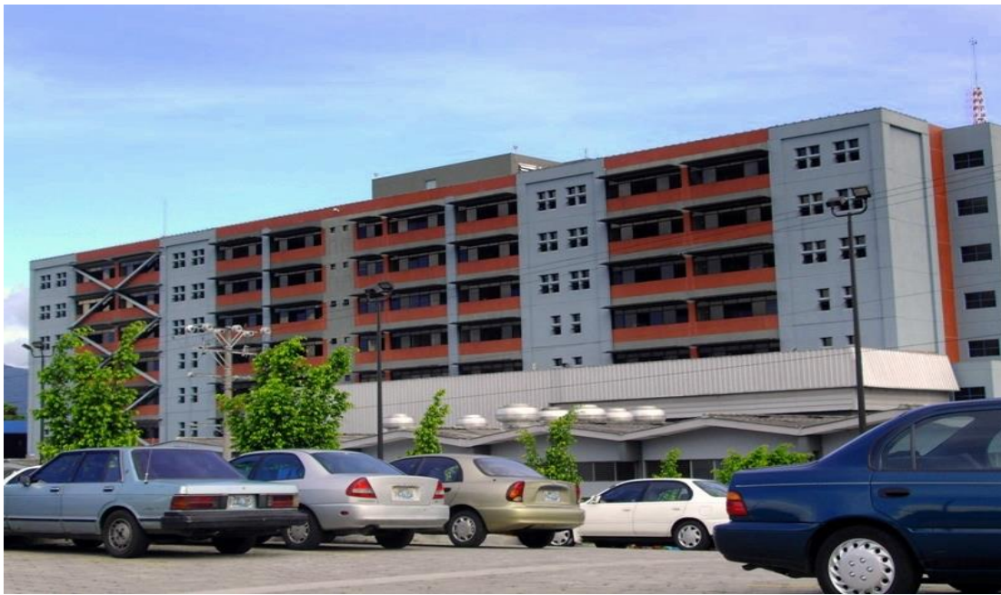
Vista frontal del consultorio de especialidades
