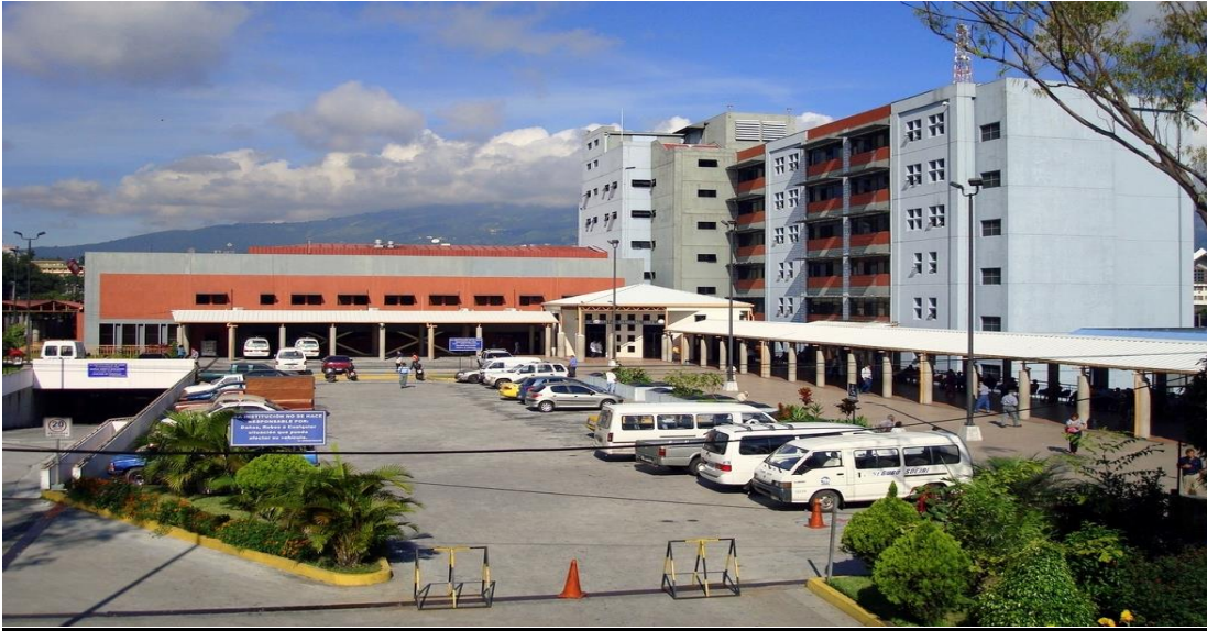
Vista frontal del hospital general y lateral del consultorio de Especialidades
