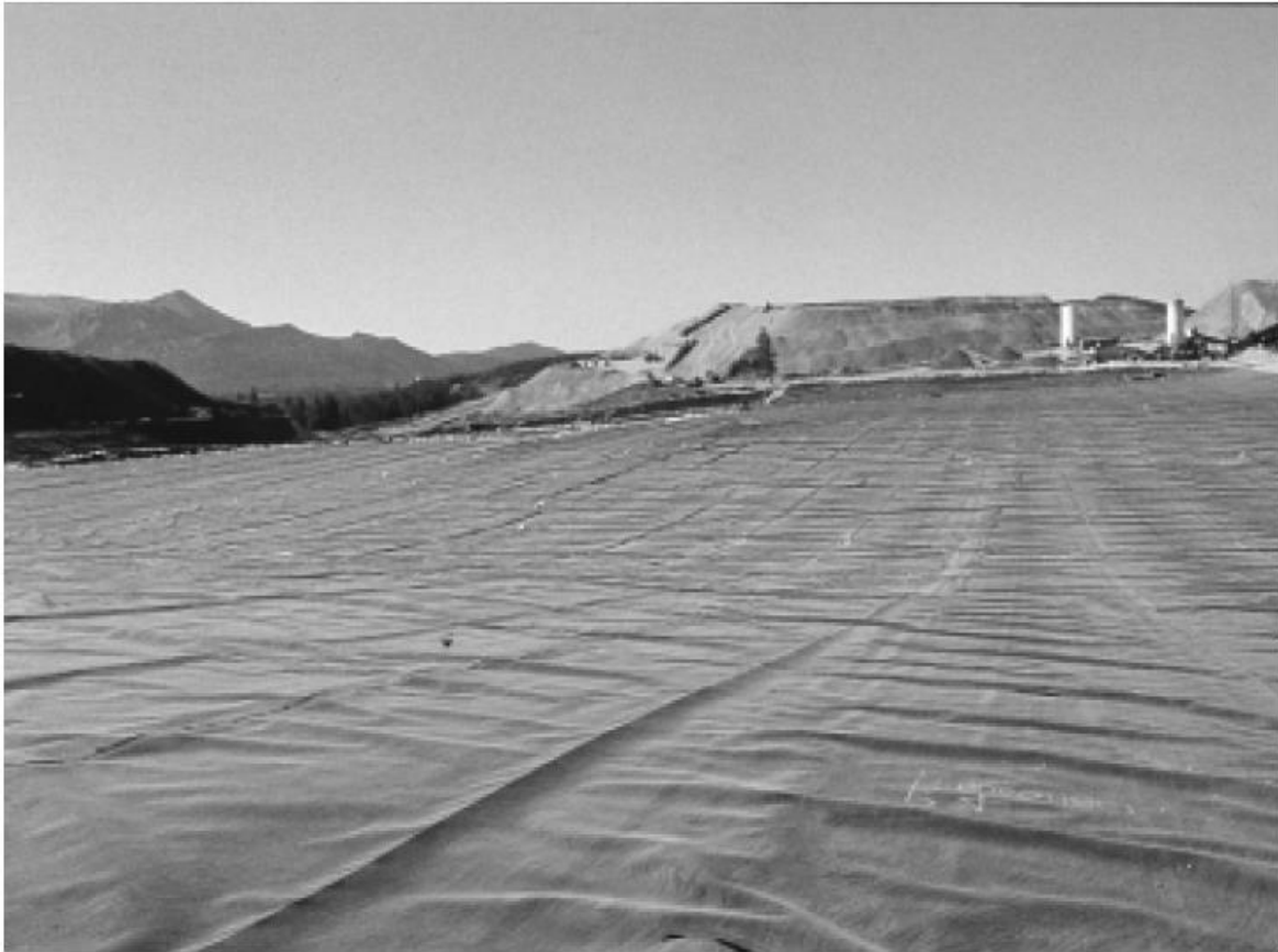
Construcción de una plataforma de lixiviación en Pikes Peak, Colorado, Estados Unidos.
