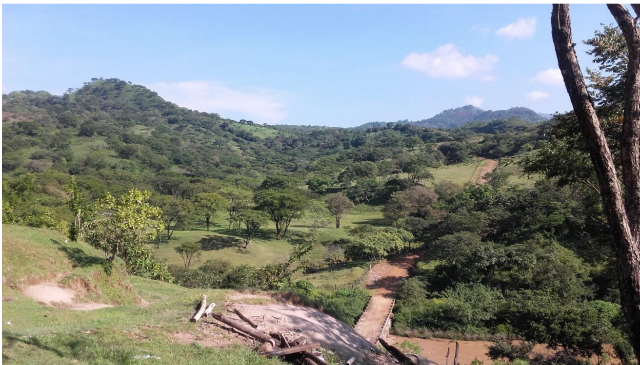
Figura 13. Vista panorámica del puente sobre Río Torola.
