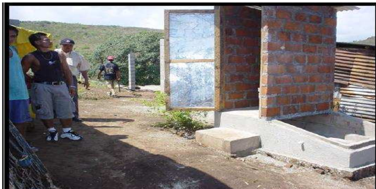
Figura 4.36 Letrina Solar con sus respectivas cámaras
