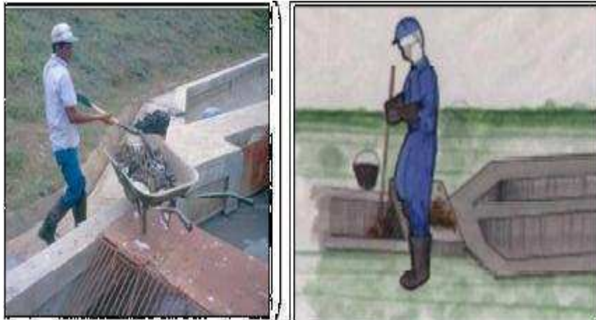
Figura 6.30 Limpieza de rejillas.
