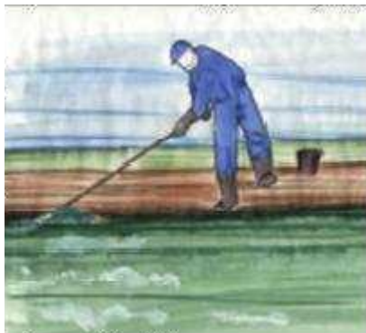
Figura 6.38 Distribución de lodos en capas en los patios de secado.
