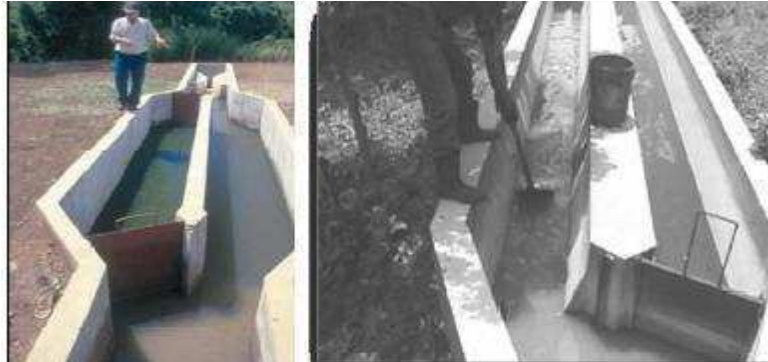
Figura 6.32 Limpieza de desarenador.
