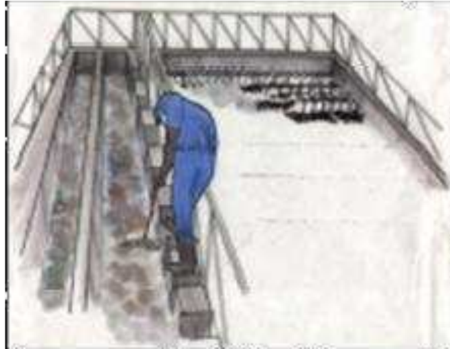
Figura 6.37 Limpieza de canales del filtro percolador.
