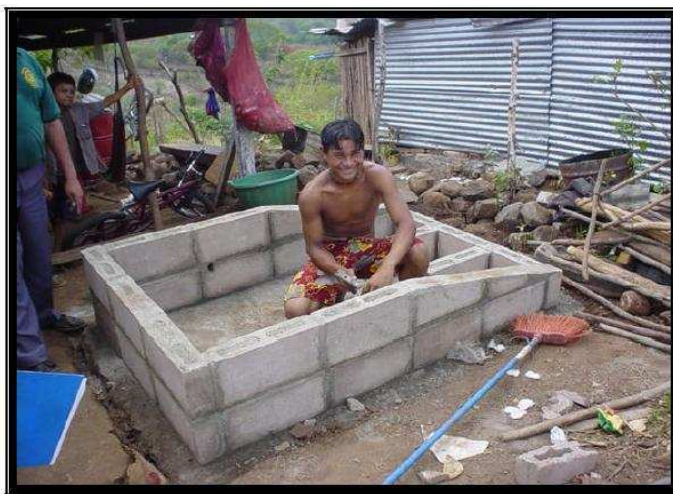
Figura 4.38 Cámara de Letrina terminada.
