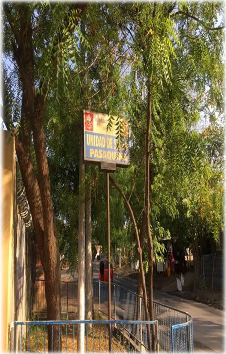
FIGURA N° 2. UNIDAD COMUNITARIA DE SALUD FAMILIAR PASAQUINA, LA UNIÓN.
