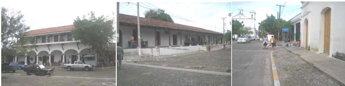
Fotografías 2, 3, y 4: fachadas de los edificios construidos alrededor de la plaza central del Centro Histórico.
