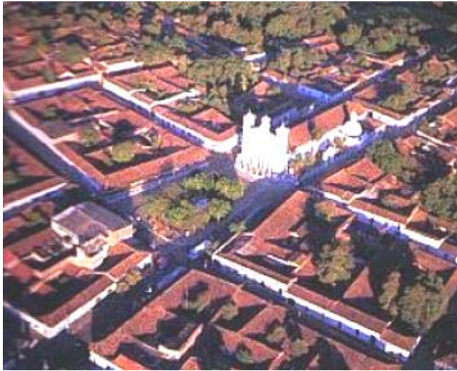
Fotografía 1: Vista aérea del Centro Histórico de Suchitoto, en donde puede apreciarse la trama de la ciudad.
