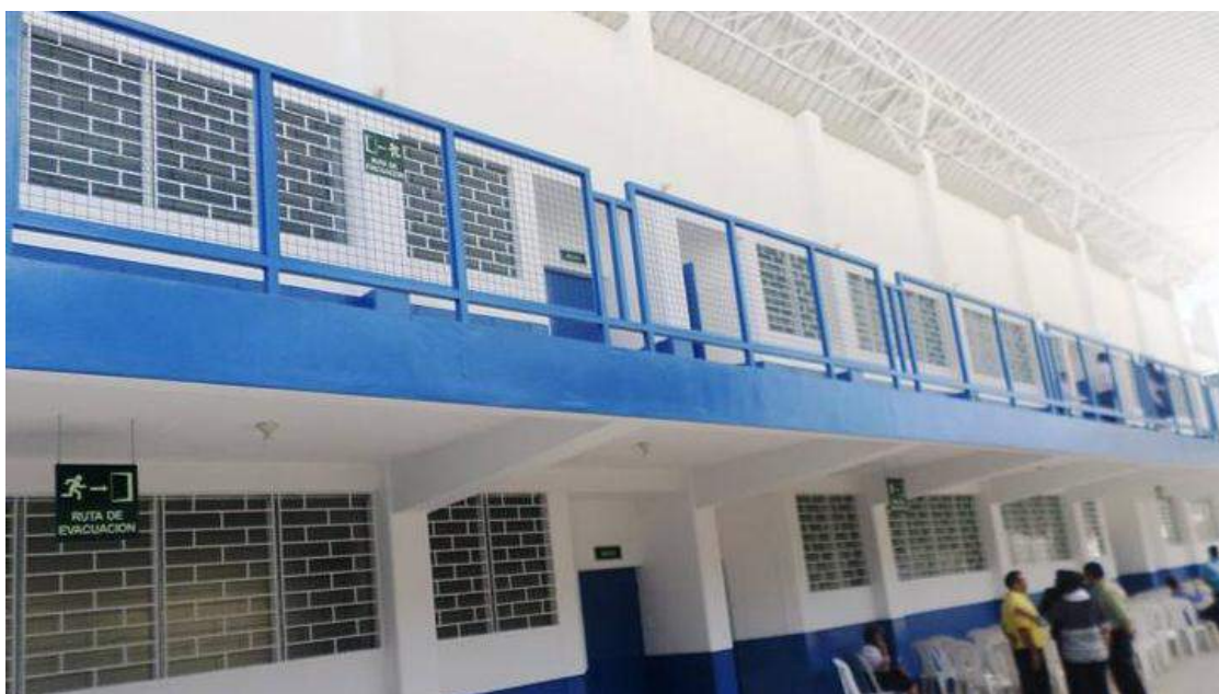
Figura 29: Instalaciones del Centro Escolar Doctor Francisco Antonio Lima.
