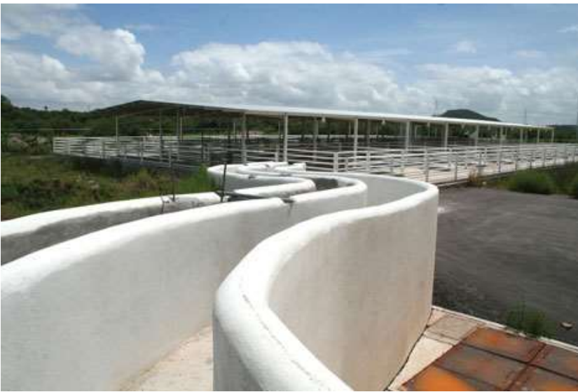
Figura N° 1 Pasillos para animales que se dirigen al cajón de aturdimiento
