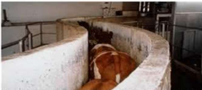
Figura N° 5 Pasillo con paredes altas que evitan la visibilidad. (20)
