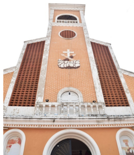
5. Fachada de la Iglesia Principal del municipio. Fuente: Catherine Guzmán
