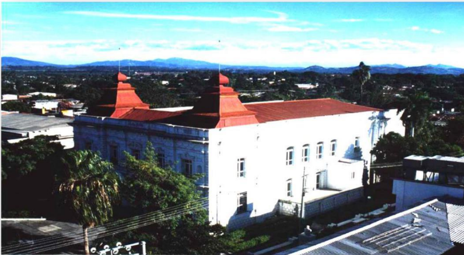
SOBRE LA FACHADA PONIENTE, OBSERVESE LA REPETICIÓN DE VANOS CON REMATE DE ARCO REBAJADO.
