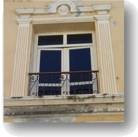
Pilastras de orden dórico y ventana de estilo neoclásico
