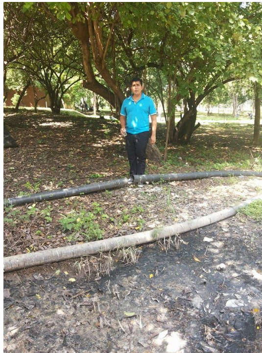
b) Tubos de descarga del agua servida de parte de los cafetines.
