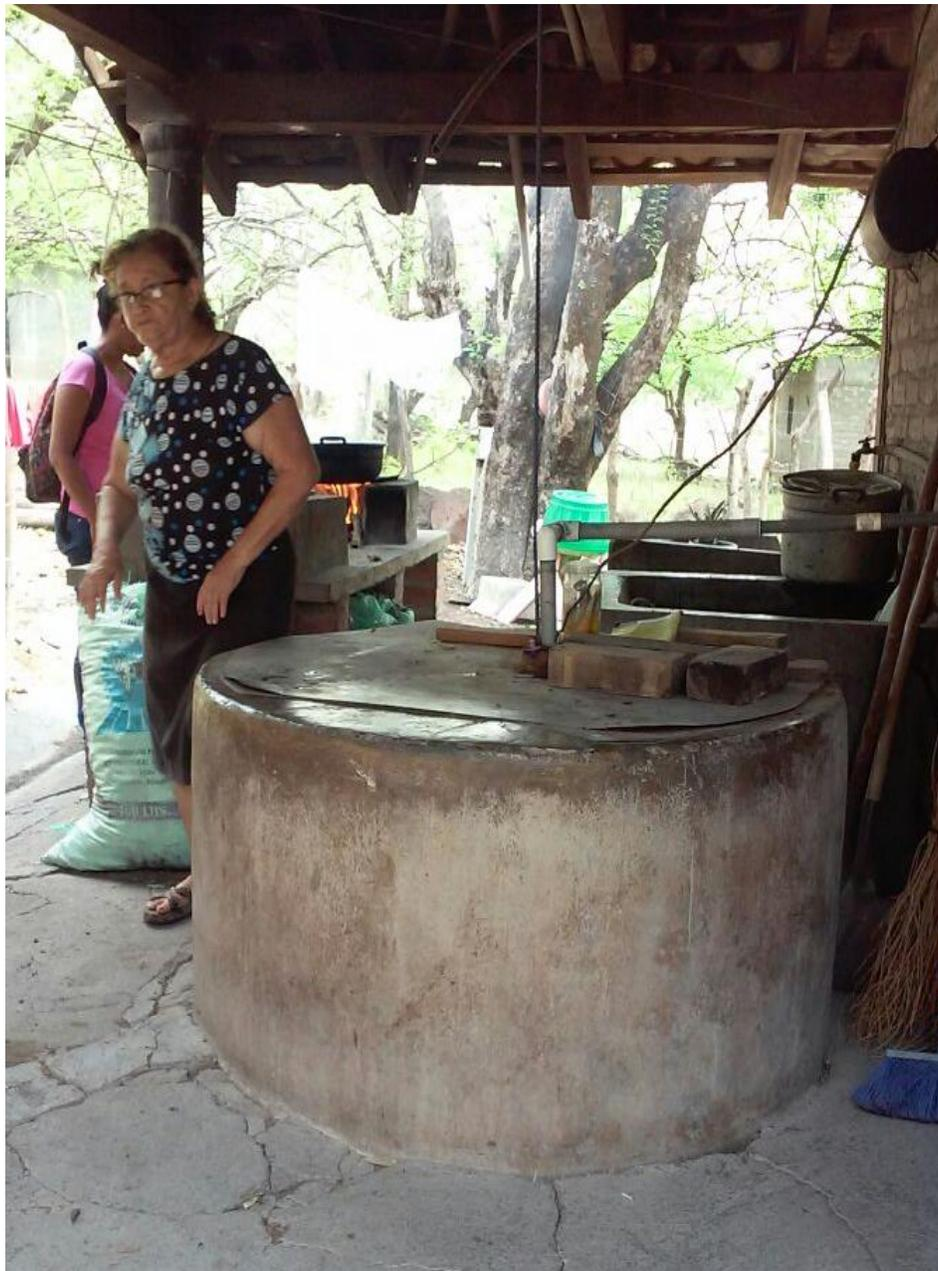
Figura 21. Pozo artesanal con un sistema de extracción de agua por medio de bomba interna y tubería de PVC.
