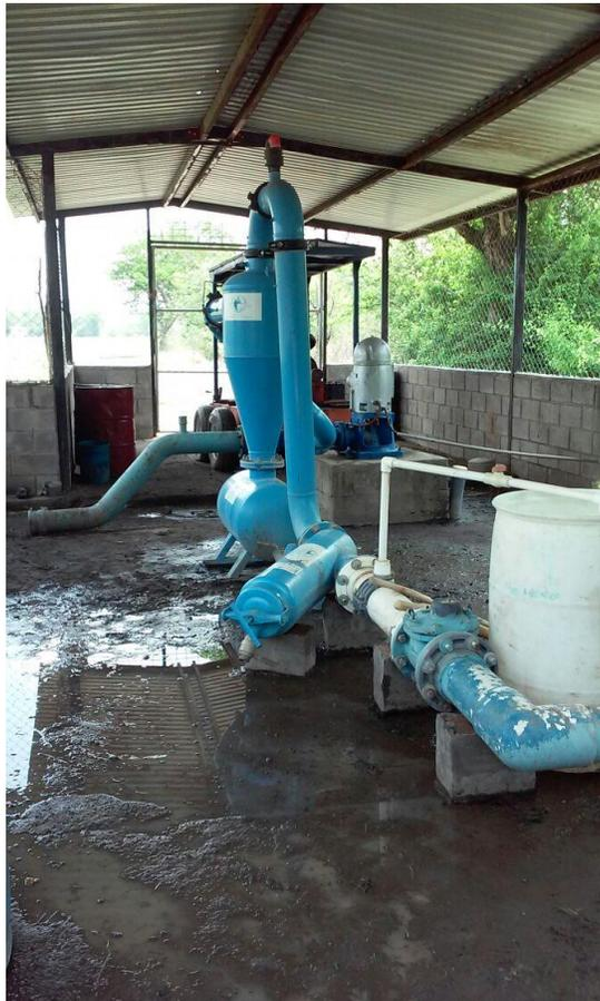
Figura 31. Planta donde se extrae el agua para riego de caña de azúcar con un caudal de 900 gpm.
