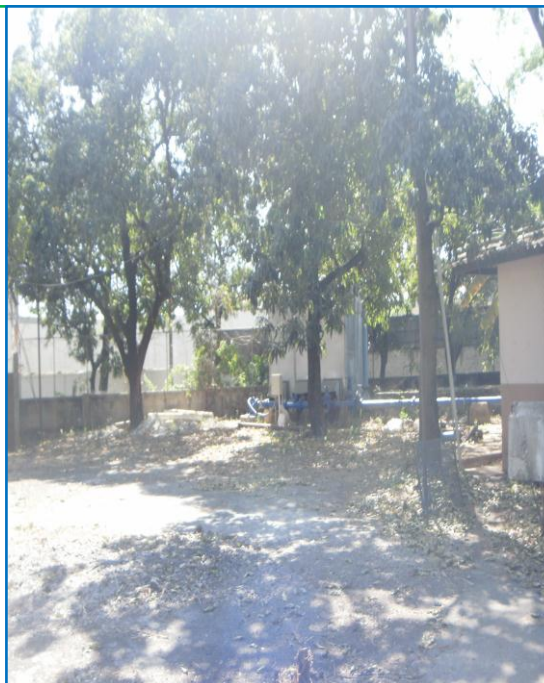
PLANTA DE BOMBEO CENTRO DE GOBIERNO II
