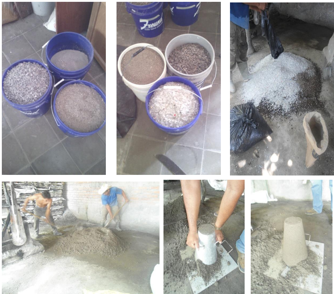
Fotografía 4.1: Procedimiento de la dosificación y mezclado
