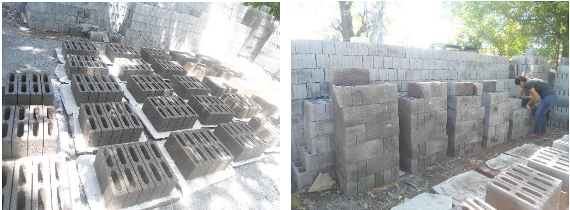
Fotografía 4.3: Procedimiento del curado de las unidades de mampostería
