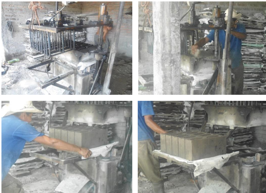
Fotografía 4.2: Procedimiento del moldeado y vibro compactación en la fabricación de las unidades de mampostería
