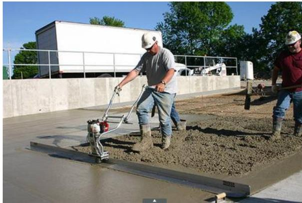
*Imagen 2.7. Empleo de reglas vibratorias para losas de pavimentos*
