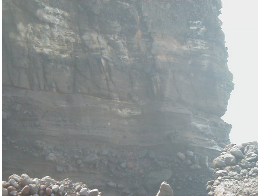
Fotografías 3-21b: Se muestra acantilados que presentan grietas que podrían dar lugar a futuras fallas 207 .
