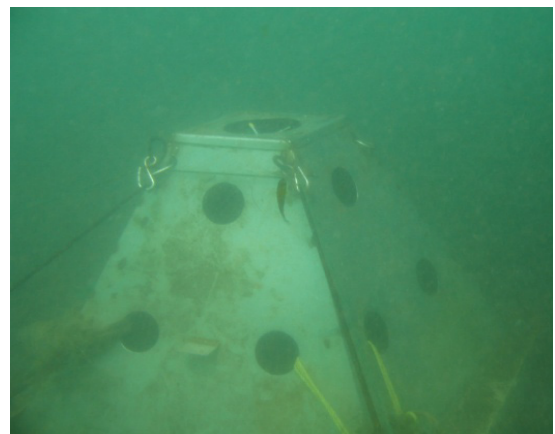
Proceso de instalación de la carcasa de la sonda ADV Triton 361 .
