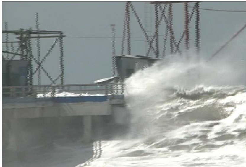
(b) Subida de las olas cubriendo la estructura del muelle.
