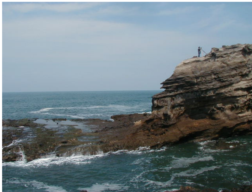
Fotografía 3-22a: Se muestran, la estabilidad del terreno en el Km 51 208 .
