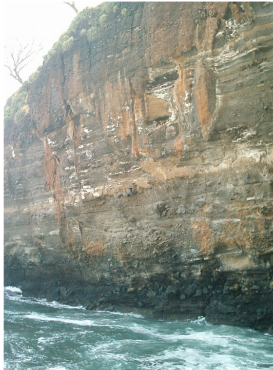
Fotografía 3-14: Forma de algunos acantilados de la Sierra El Bálsamo 179 .
