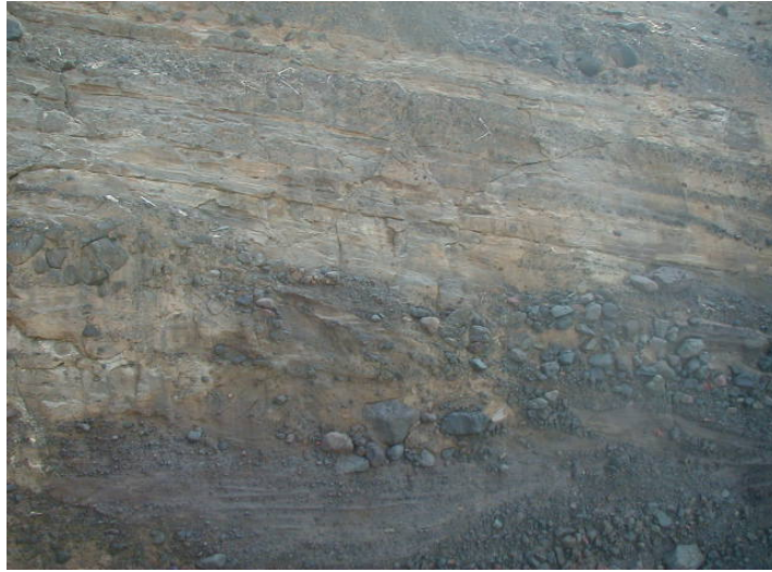
Fotografía 3-16a: Punto número uno, Kilómetro 51 sobre la carretera El Litoral 184 .
