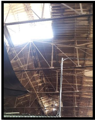
Figura 5: Cubierta del Mercado #1.
