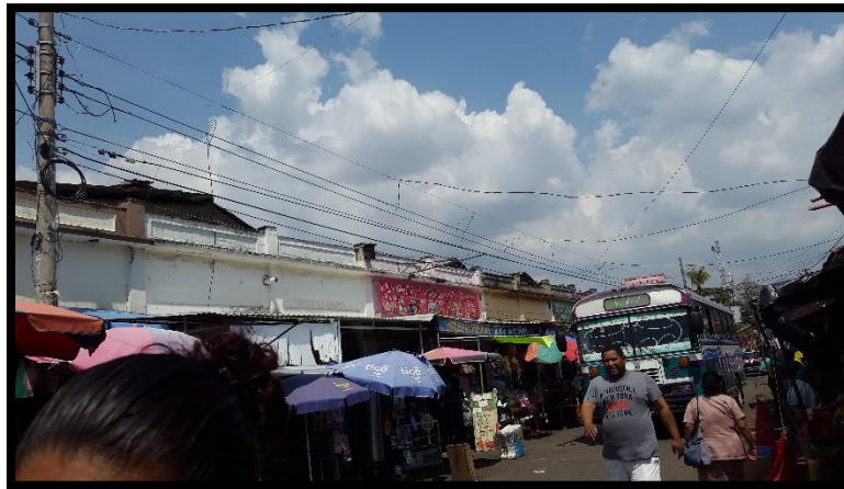
Figura 19: tendido electrico en el exterior del mercado #1. Fuente: Autoría propia.
