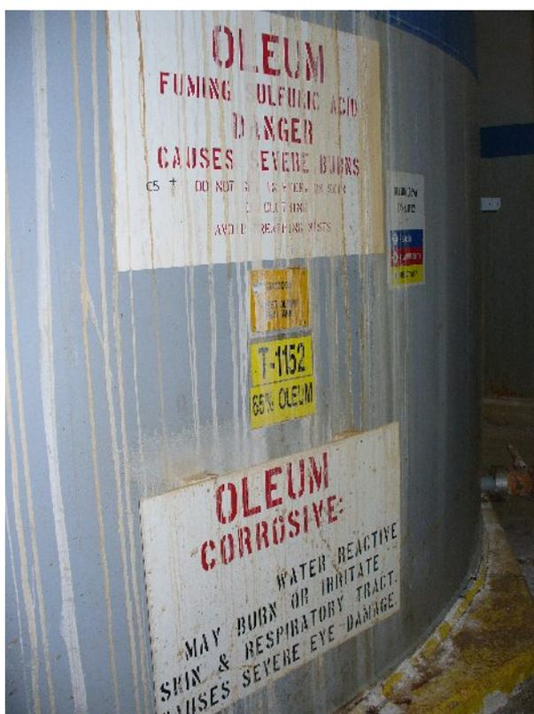
Fig. 4.1. Tanque T-1152 debidamente rotulado.
