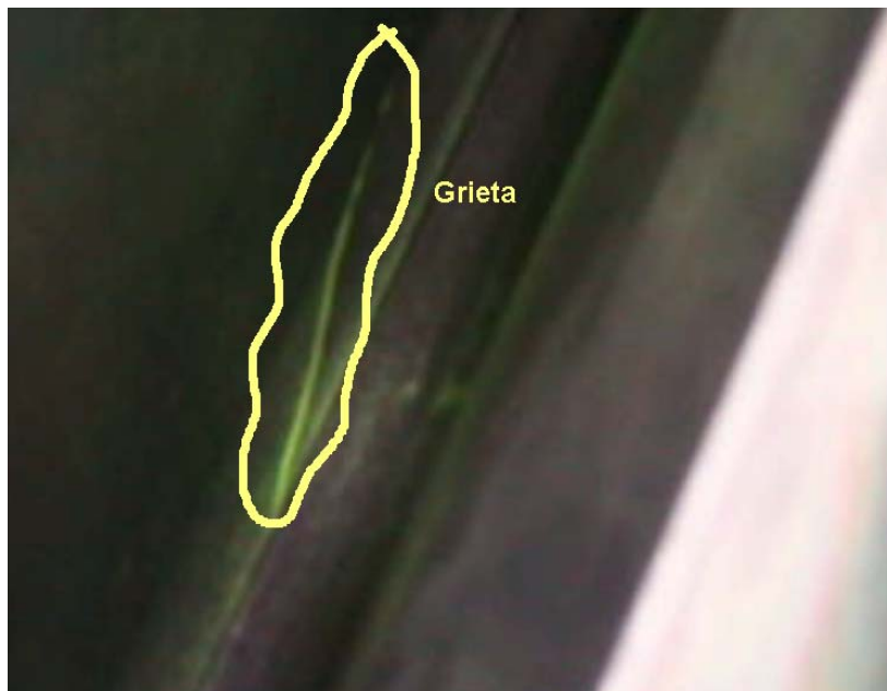
Fig. 10-5: aplicación partículas e inspección de grietas.
