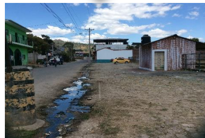
Desague de aguas residuas
