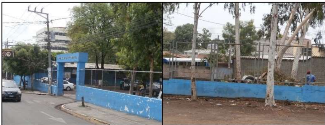
Escaso Mantenimiento en las Instalaciones
