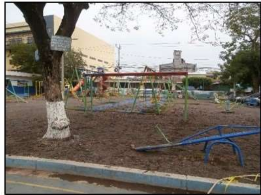
Juegos Deteriorados Figura 7 Fuente: Elaboración Propia
