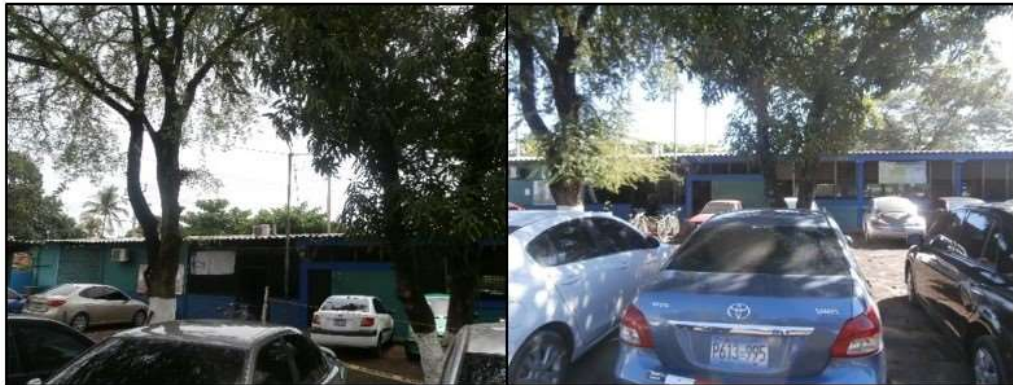
Of. Administrativas Inadecuadas / Estacionamiento Reducido Figura 11
