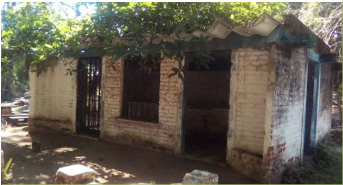
Infraestructura de Cafetines Existente.
