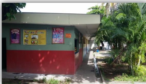
FOTO 58: PABELLON DE AULAS PONIENTE
