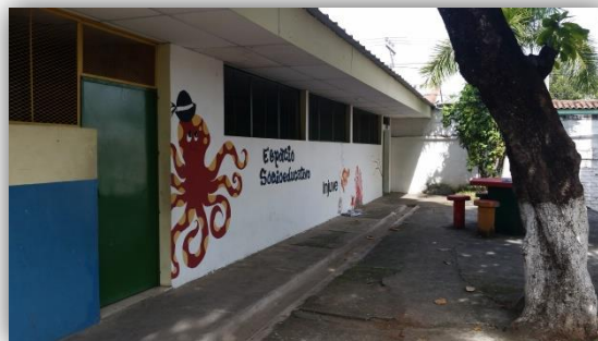
FOTO 59: PABELLON DE AULAS ORIENTE
