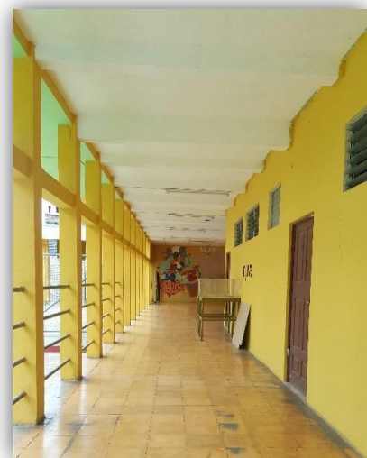
FOTO 51: PABELLON DE AULAS
