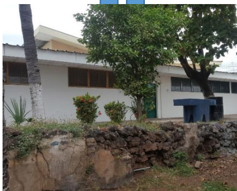
Muro de contención, en la zona de las aulas de taller. Al oriente del inmueble.
