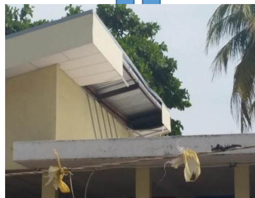
Fascia del edificio, Zona de oficinas.
