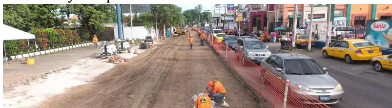
Imagen 32. Trabajadores de FOVIAL inspeccionando obras en Av. Roosevelt
