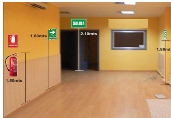
Figura . Altura de las señales
