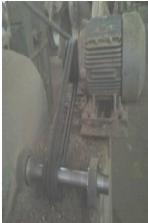
Foto 30. Cerca de donde pasa el operario se observa engrane sin proteccion ni senalizacion.
