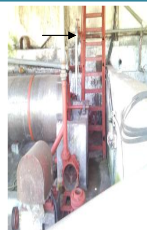
Foto 50. La escalera que une pilas de fermentacion y lavadoras como se observa en la figura la inclinacion puede
