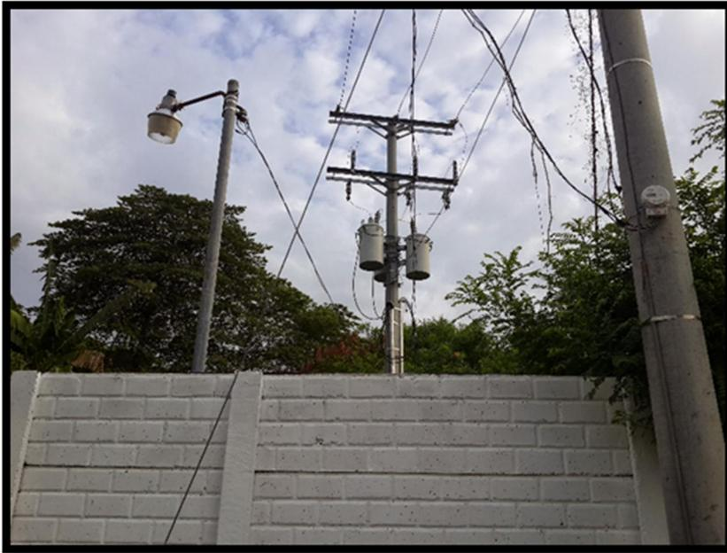
*Imagen: 6 Subestación Eléctrica de Estación de Bombeo*
