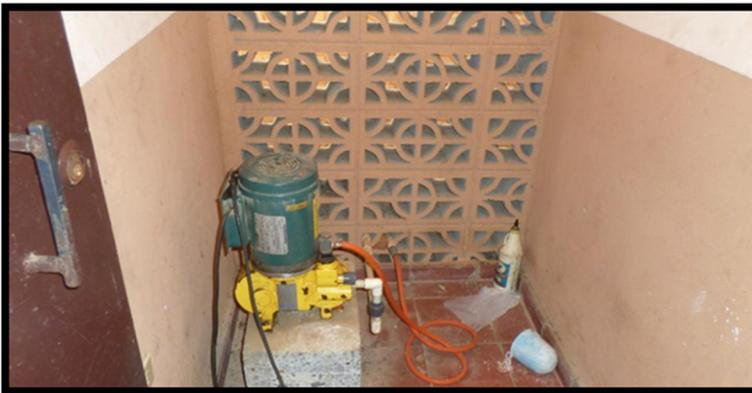
*Imagen: 8 Equipo de Inyección de Cloro al Sistema de Bombeo*
