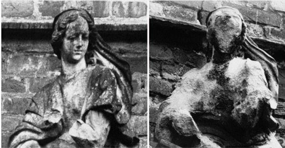
Figura 2. 13 Consecuencias de la lluvia ácida sobre edificios (Bell, 2015)
