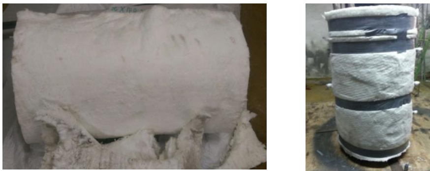
Figura 54. Proceso de insulación del tanque acumulador.
