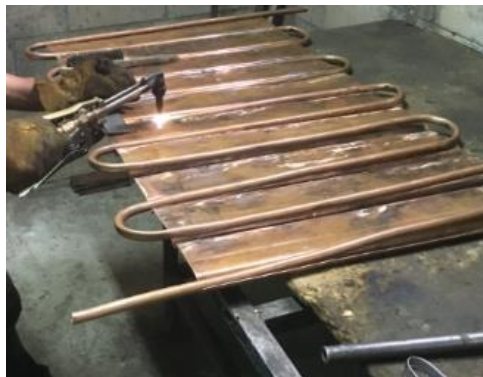
Figura 59. Uniendo con soldadura placa absorbente al serpentín.
