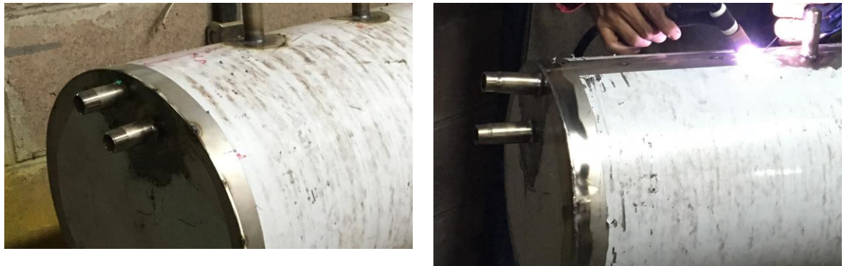
Figura 52. Soldadura de tanque acumulador.
