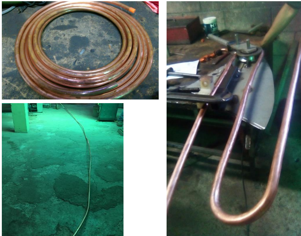
Figura 58. Fabricación de serpentín.
