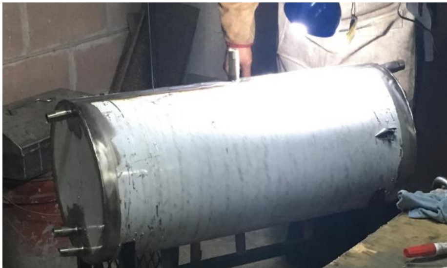
Figura 53. Limpieza de rebabas de soldadura.
