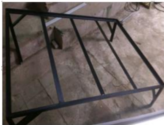
Estructura de soporte para el colector.
