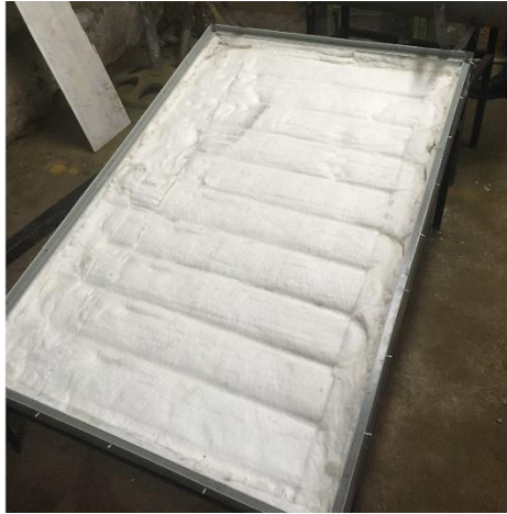
Figura 60. Instalación de aislante al cajón del colector.
